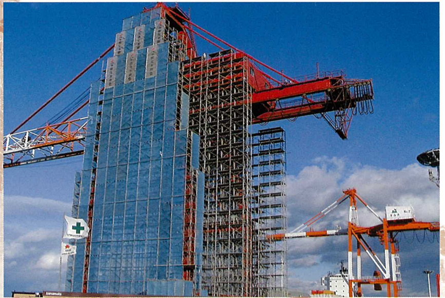
稼動向け塗装作業が進むガントリークレーン
