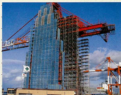
八戸港多目的国際物流ターミナル
