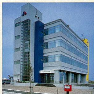
八戸港貿易センター
