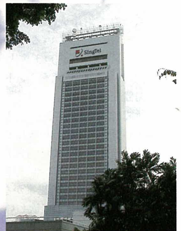
「中心街を見下ろし高くそびえるシンガポールテレコムの本社ビル」
