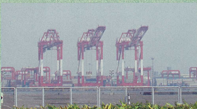
高雄のガントリークレーン
