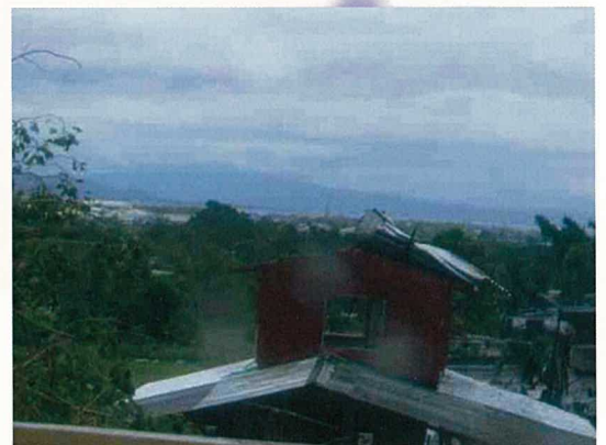
崩壊した家屋
