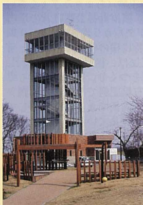
「グレットタワーみなと」外観
