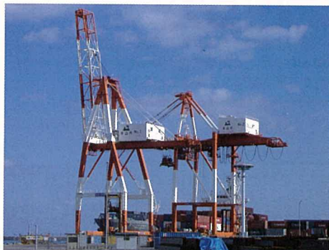
ガントリークレーン
