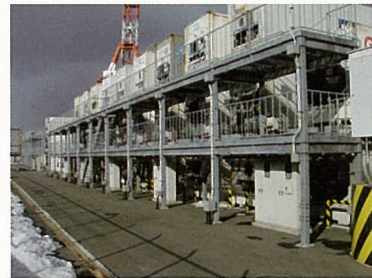
冷凍コンテナ用コンセント
