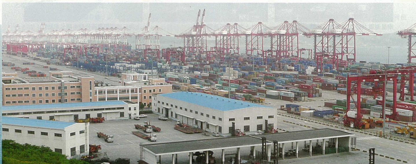
高台から望む、羊山深水港の港湾施設
