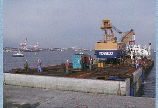
八太郎北防波堤におけるケーソン据付状況 (提供：国土交通省 八戸港湾・空港整備事務所)
