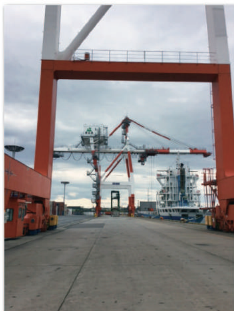
ガントリークレーン
