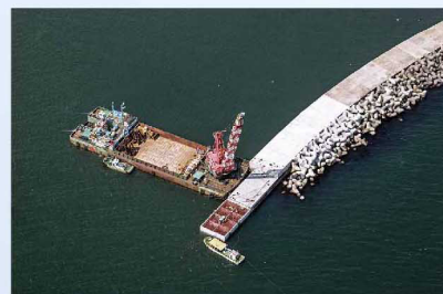
中央第1防波堤のケーソン据付状況
