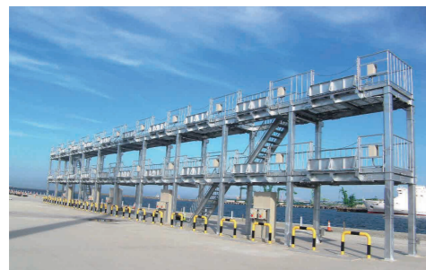
リーファーコンテナ電源設備
