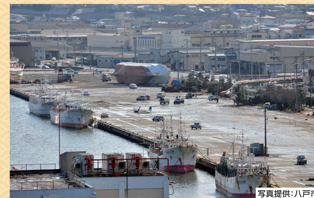
写真提供:八戸市 東日本大震災の被害の様子
