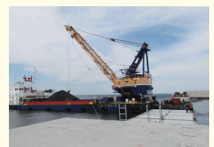
ケーソン据付状況 (令和6年5月撮影)
