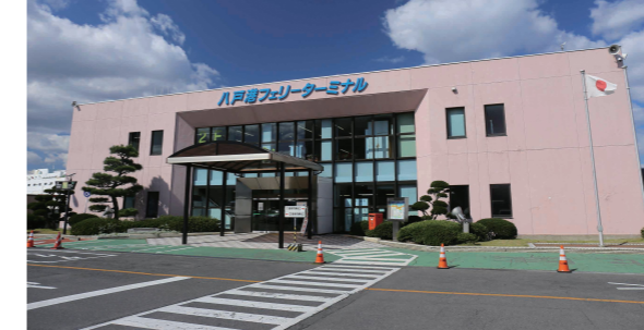
現八戸港フェリー埠頭ターミナルビル
