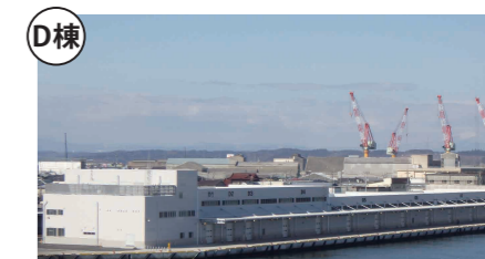
主に沿岸や八戸沖での日帰り操業で水揚げされる生鮮魚介類や活魚を中心に荷さばきが行われる施設。
