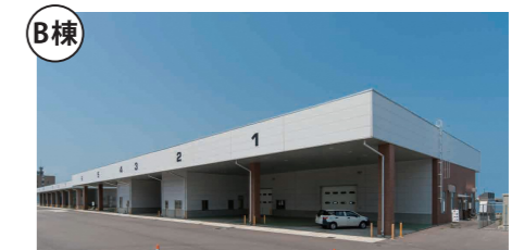
B棟 主に中型イカ釣船による冷凍イカ(スルメイカ、アカイカ)、小型イカ釣船による生鮮スルメイカの荷捌き。
